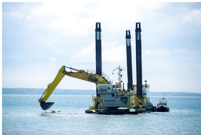
Figur 2.1:4. Schaktning från pråm under förnyelsen av den sydliga kabelförbindelsen.
